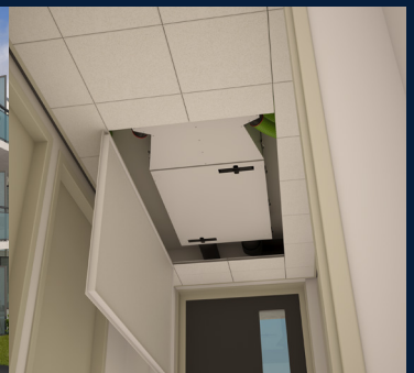
Compacte Renovent Sky met enthalpiewisselaar, toegepast boven een verlaagd plafond
